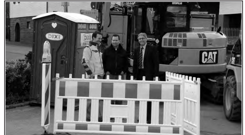
Raser: 30er Schild, Ampel und Baustraße nützen nichts, in der Baustelle in Affolterbach wird gerast. Sehr zum Leidwesen der Arbeiter, die laufend „in Deckung gehen“ müssen.
