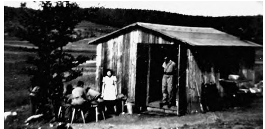
Die neue Verpflegungsbude am Dachsberg. (1)
