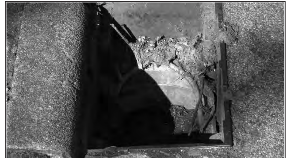
Übler Scherz: Während der Aschbacher Kerwe „verschwand“ in der Gartenstraße ein Kanaldeckel. Wäre ein Besucher in das Loch hineingetreten, hätte das üble Folgen für ihn haben können.
