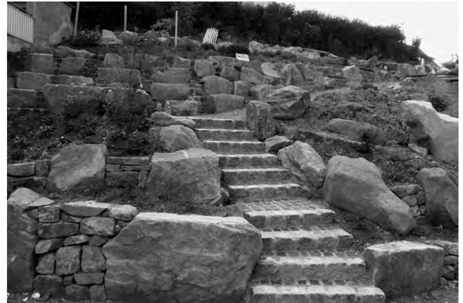
Das Grundstück Ludwigstraße 44 wurde von den beiden Gartenbau- firmen Benjamin Keller und Thomas Müller saniert und gestaltet.
